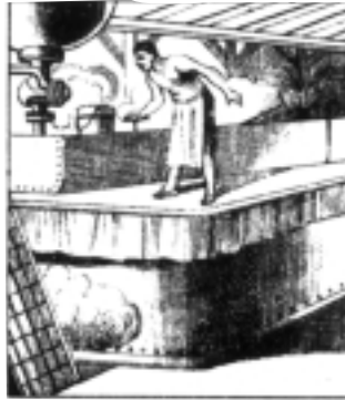
Le sirop clarifié et généralement très coloré, passe ensuite sur de petites colonnes cylindriques remplies de sucre normal en grains pour s'y DÉCOLORER. Les propriétés décolorantes du sucre ont été trouvées en 1811 par Figuier, pharmacien à Montpellier.
